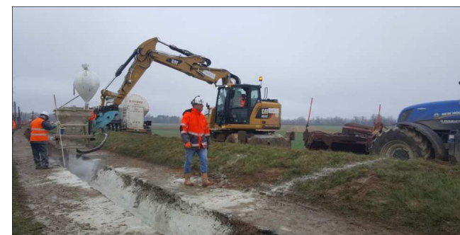
Travaux de confortement des digues à Sigloy
