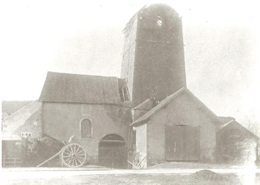
Façade côté rue de la Verrerie du four à combustion continue.
